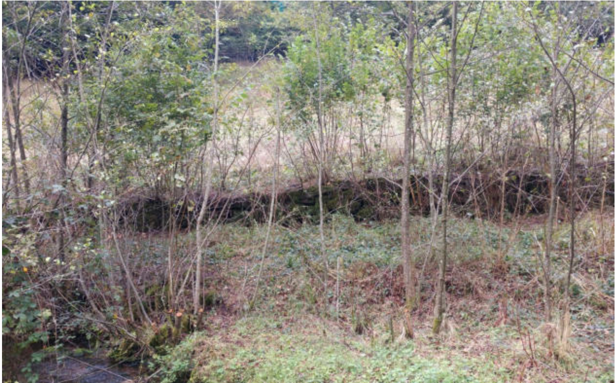
Abb. 41: Im Dobelbachtal wurde diese eingewachsene Trockenmauer wieder freigestellt.
